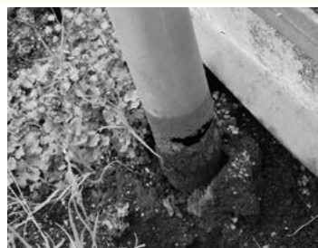
老朽化したトマトハウスのパイプ
