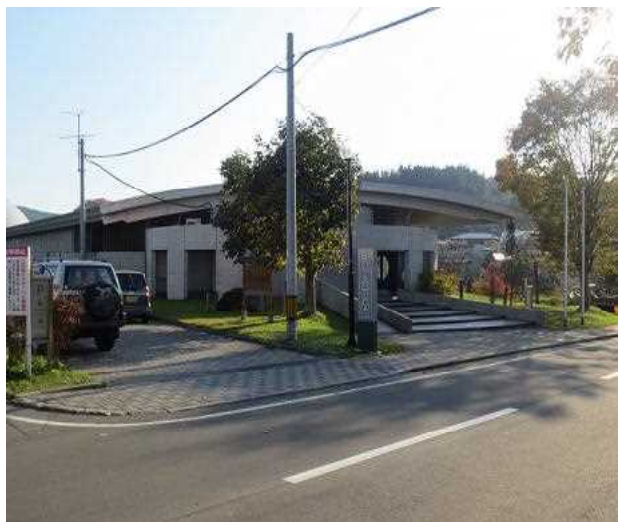
・田子町立図書館、タプコピアンプラザ
