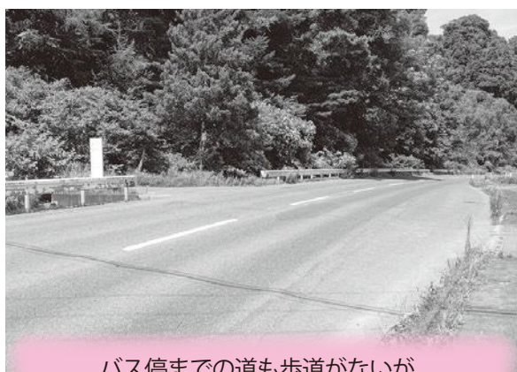
バス停までの道も歩道がないが、 バス停がある場所もスペースがない状態
