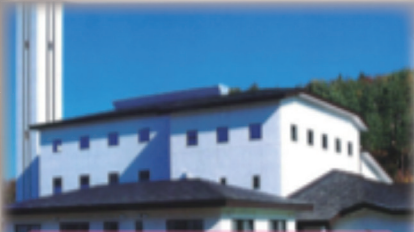
三戸地区クリーンセンター （可燃ごみ処理施設）
